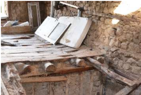
Şekil 16. Çatı kat döşemesi
