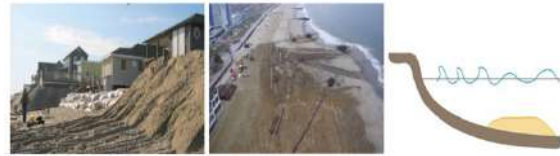
Görsel 3. Yumuşak kıyı mühendislik uygulamaları soldan sağa; kumul besleme, kıyı ve profil besleme, bar besleme
