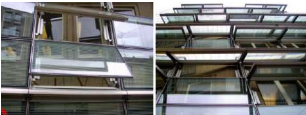
Şekil 3. Prizmatik Sistem (Çiftçi ve Arpacıoğlu, 2021).
