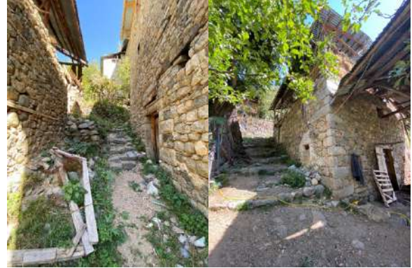
Şekil 5. Yapı duvarlarıyla sınırlanmış sokak
