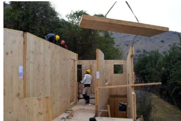
Şekil 9. CLT binasının yerinde uygulanması ve montaj işlemi (Thomas F. J., 2019).
