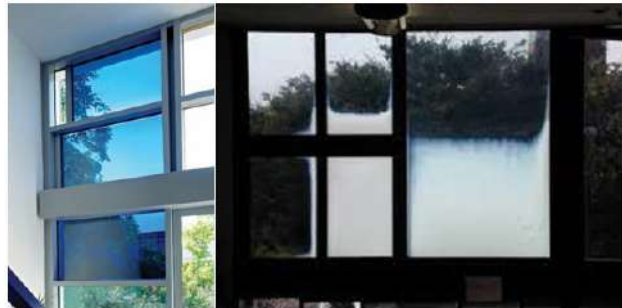
Şekil 5. Fotokromik Cam, Termokromik Cam (url-5)
