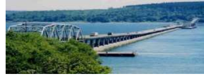
Görsel 16. Hold Canal Yüzer Köprü, ABD
