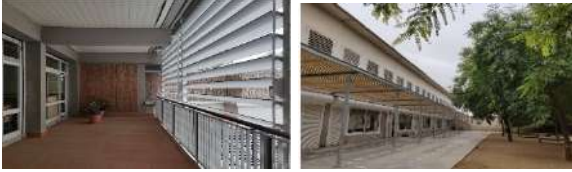
Şekil 8. Poblenou ve Villa Olimpica okullarında güneş kontrolü elemanları (soldan sağa doğru) (Cartalis, 2021b)
