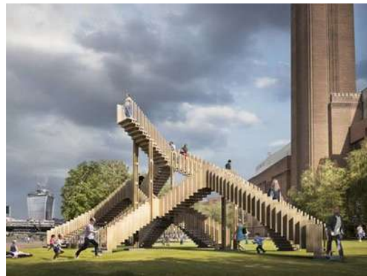
Şekil 15. CLT'den üretilmiş merdiven 'Sonsuz merdiveni' (URL-6)
